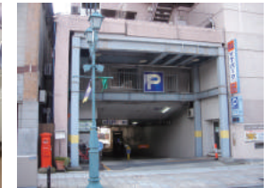
駐車場入口(1F 2.6m、B1F 2.0m)
